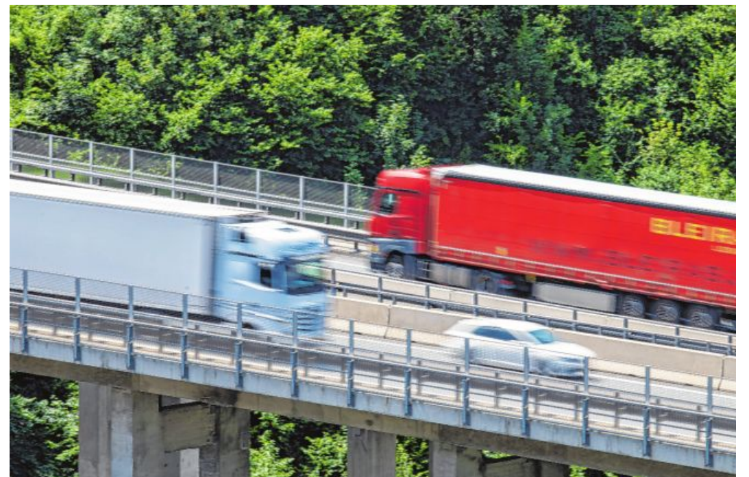
Im ersten Halbjahr rollten wieder 1,2 Millionen Lkw über den Brenner, im Vorjahr waren es 2,4 Millionen. Foto: Falk
